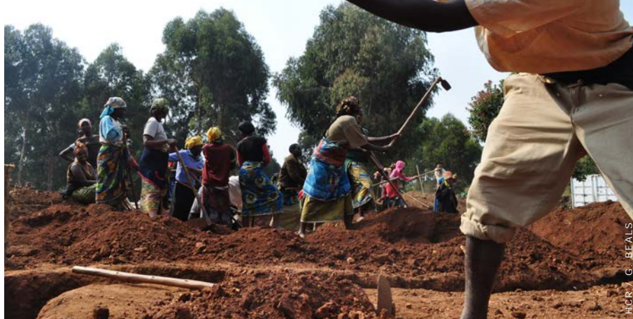
Des réfugiés congolais (RDC) construisent des équipements au camp de Kigeme I.
