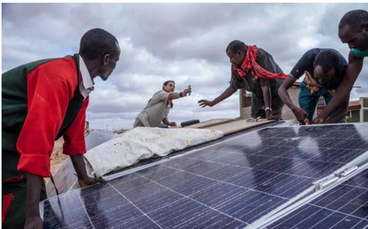
Des techniciens formés, issus de la population réfugiée et de la communauté d'accueil, assurent l'entretien d'un panneau solaire qui a été cassé. ©UNHCR/Diana Diaz
