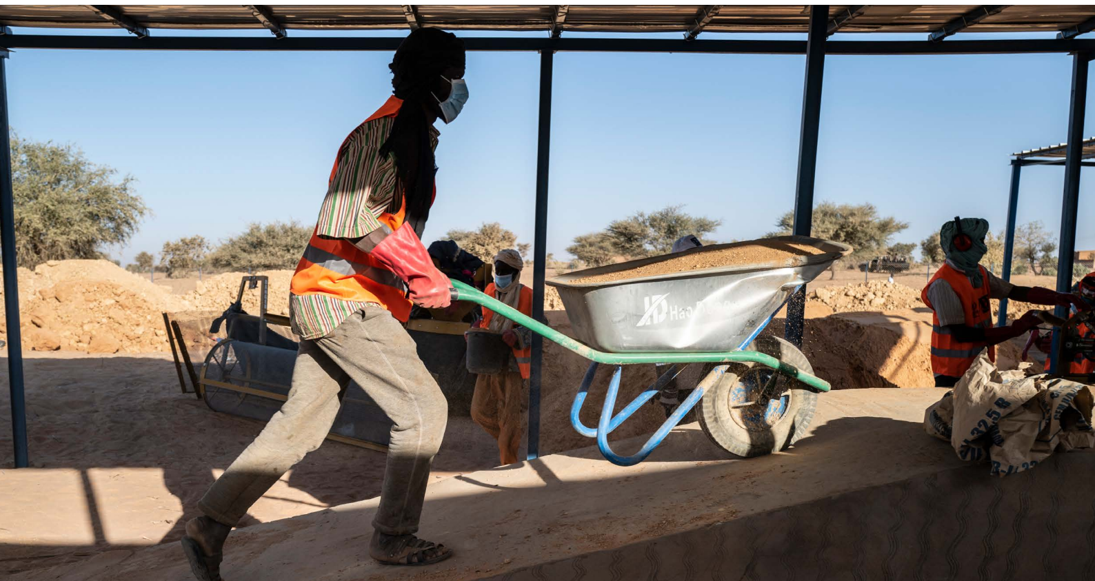
Des briquetiers travaillent à Ouallam, au Niger, pour fabriquer des briques à emboîtement et respectueuses de l'environnement qui sont utilisées pour construire de nouvelles habitations résistantes aux risques naturels pour les réfugiés vulnérables et les membres de la communauté d'accueil. © HCR/Sylvain Cherkouli
