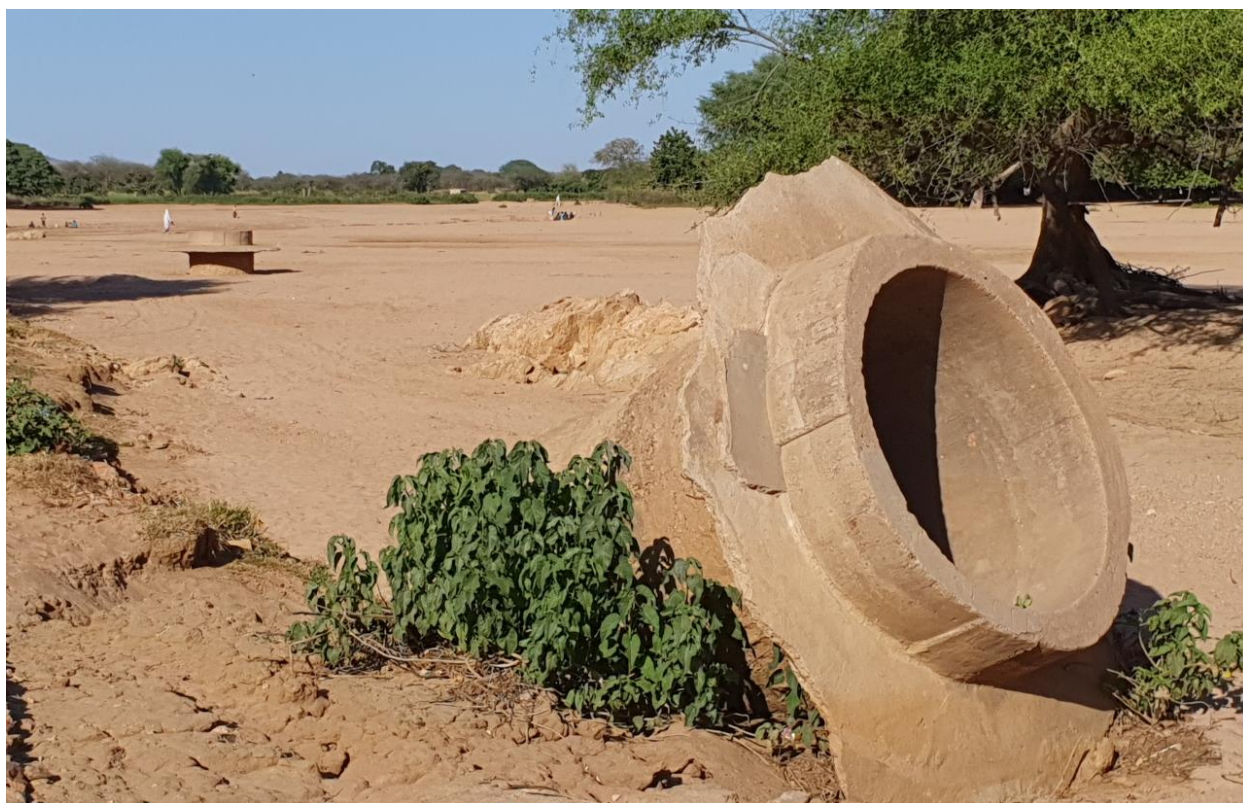
Figure 1. Puits détruits par le ruissellement, Hadja Hadid, Tchad.
