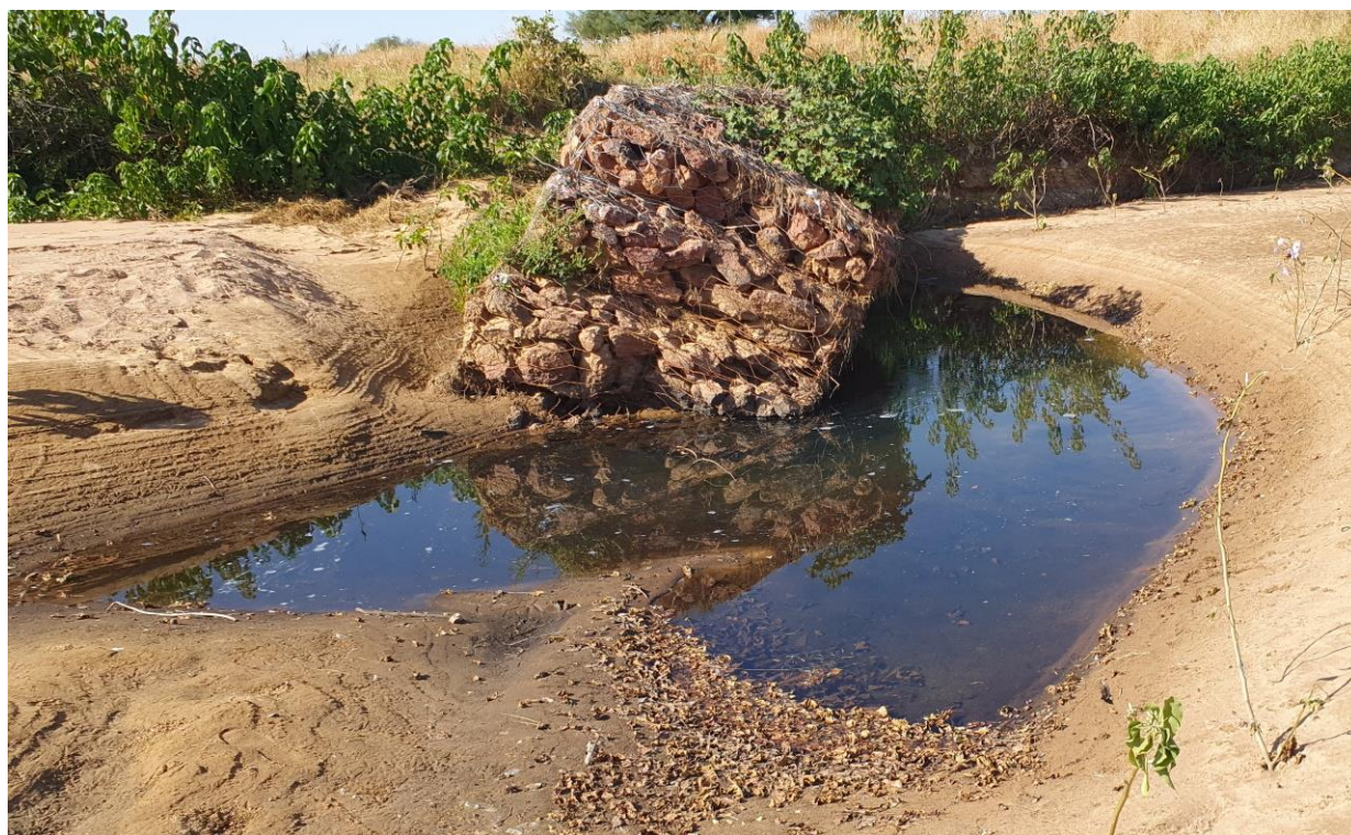
Figure 4. L'érosion a déstabilisé le mur de gabions, faute de géotextile et de fondation adéquats. La durabilité du fil de cage est aussi préoccupante. Hadja Hadid, Tchad.
