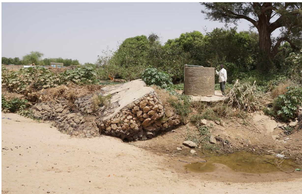
Figure 5. Déstabilisation et défaillance des travaux de protection, Treguine, Tchad.
