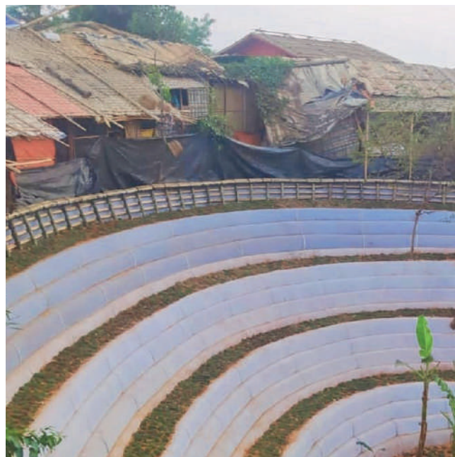
Terrassement en géotubes. Inter-Sector Coordination Group, 2022
