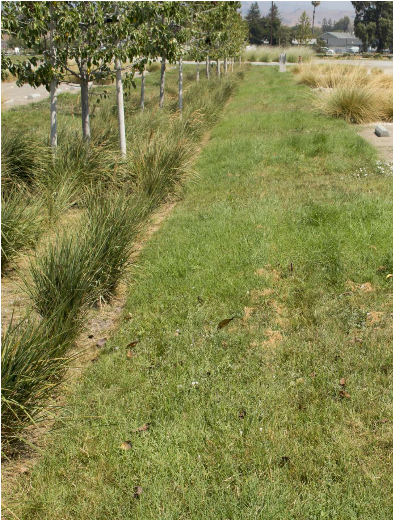
Rigole de drainage intégrée à une aire de stationnement.
