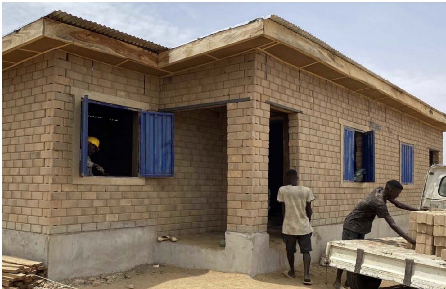
Logement double construit avec des BATCs, Nigéria
