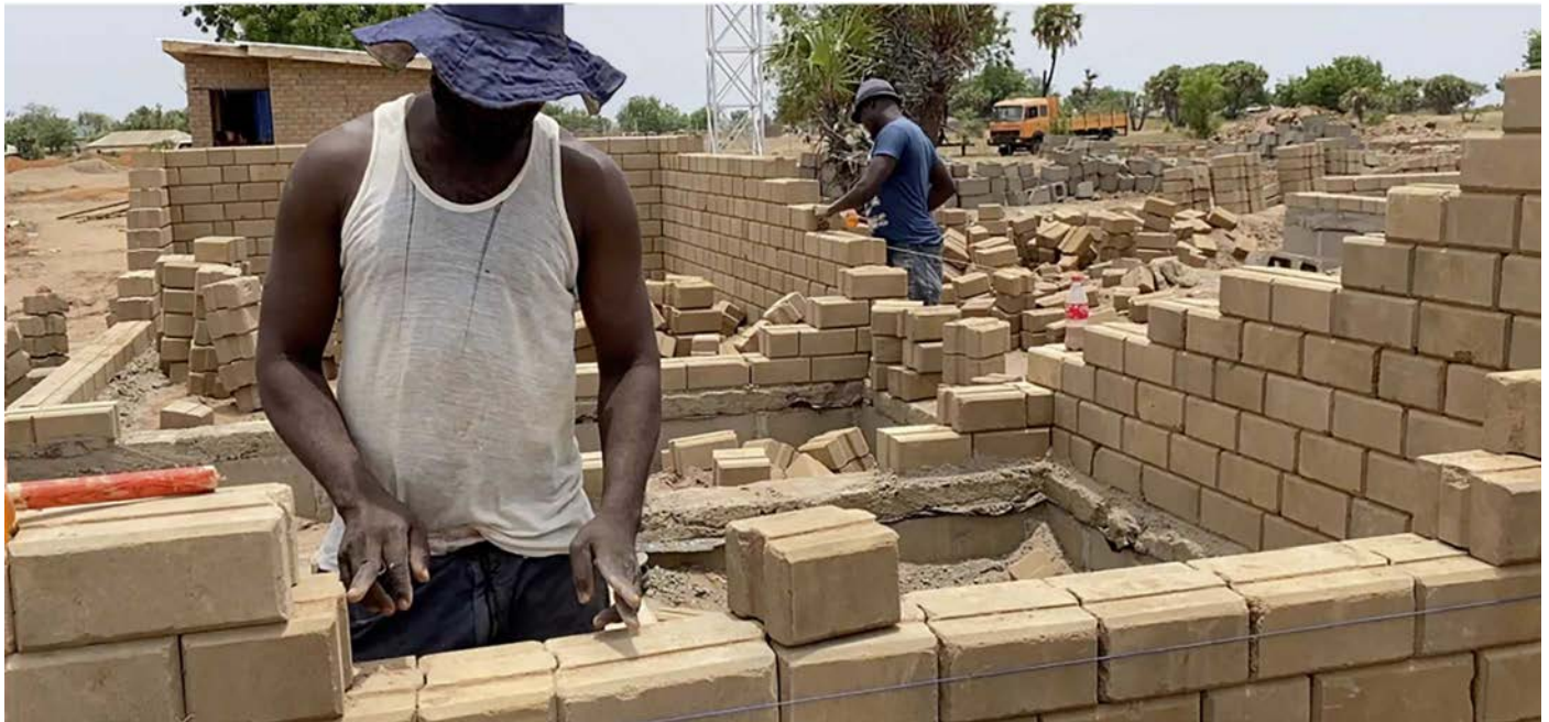
Pose des blocs, construction en BATCs, Nigéria
