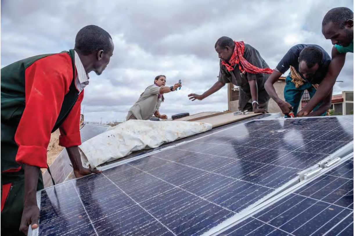
فنيون محربون من اللاجئين والمجتمع المضيف يقومون بأعمال صيانة لألواح مكسورة للطاقة الشمسية. © UNHCR/Diana Diaz
