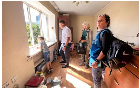
Керівник Вінницького регіонального офісу УВКБ ООН відвідує будинок, пошкоджений внаслідок обстрілу, щоб оцінити потреби. © УВКБ ООН
