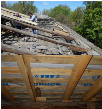
Фото зверху демонструє пошкоджені обстілами дах. На фото внизу зображений відремонтований дах. © УВКБ ООН
