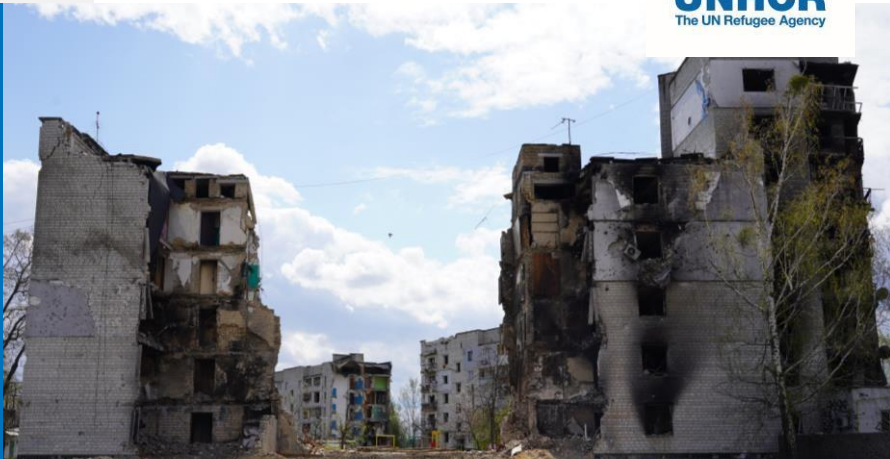
Повністю зруйнований багатоквартирний будинок у Бородянці, недалеко від Києва
